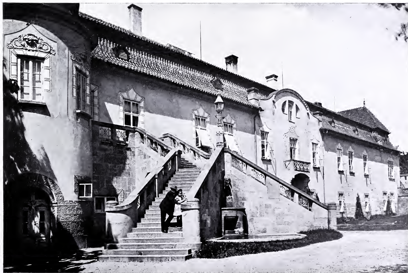
PŘESTAVBA ZÁMKU HOLOVOUSY. — ZAHRADNÍ PRŮČELÍ. Arch. Jan Vejrych, c. k. stav. rada v Praze.
